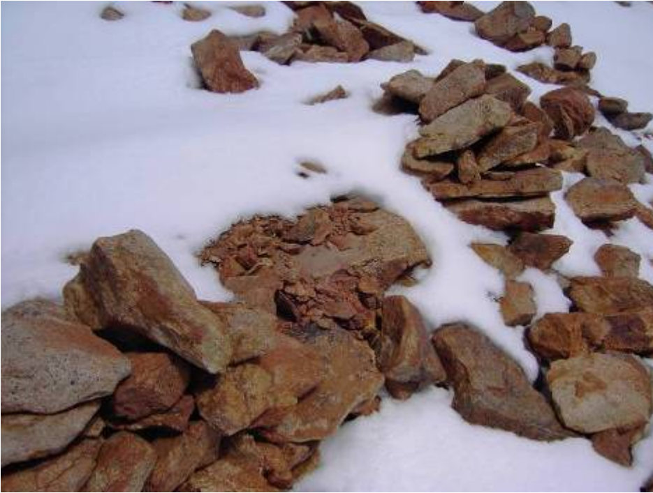
Figura 8: muro de contención de un segmento de camino ubicado a 5.800 metros, cerca de la cumbre del nevado de Chañi.
